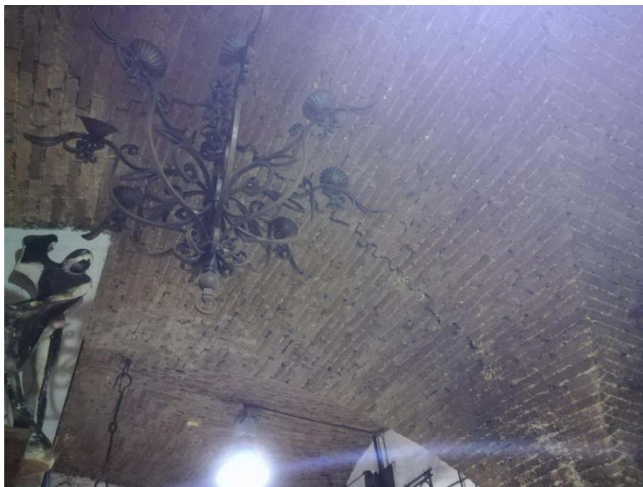
Lesione sulle volte a crociera – vano T12
